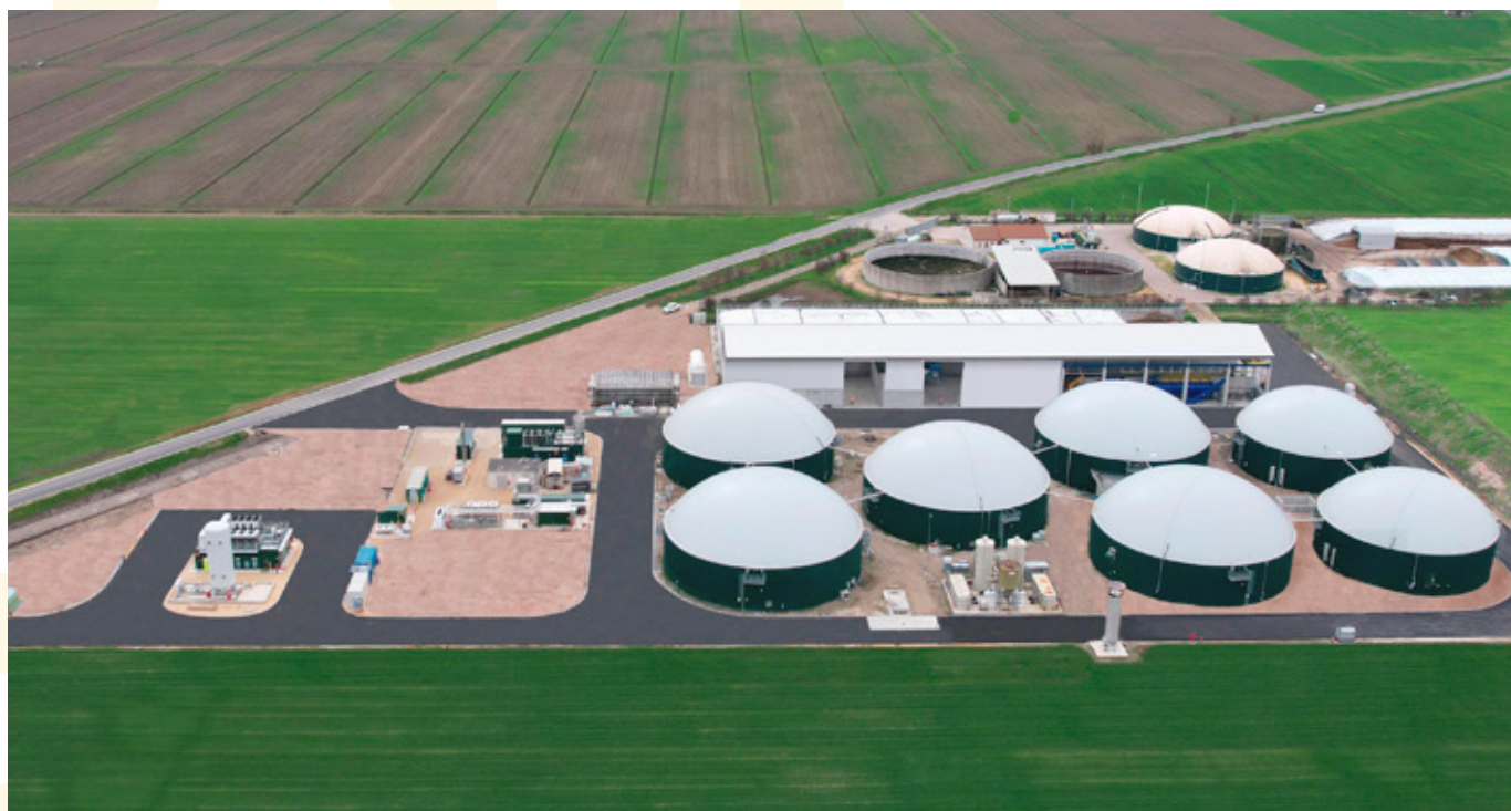
Impianto Femo Gas Ariano nel Polesine (RO)
