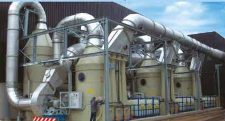
Batteria di Venturi Scrubber da 370.000 m<sup>3</sup>/h da trattamento RSU
