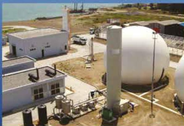
Linea di trattamento Biogas da Digestione Anaerobica Fanghi con Desolfatore Biologico
